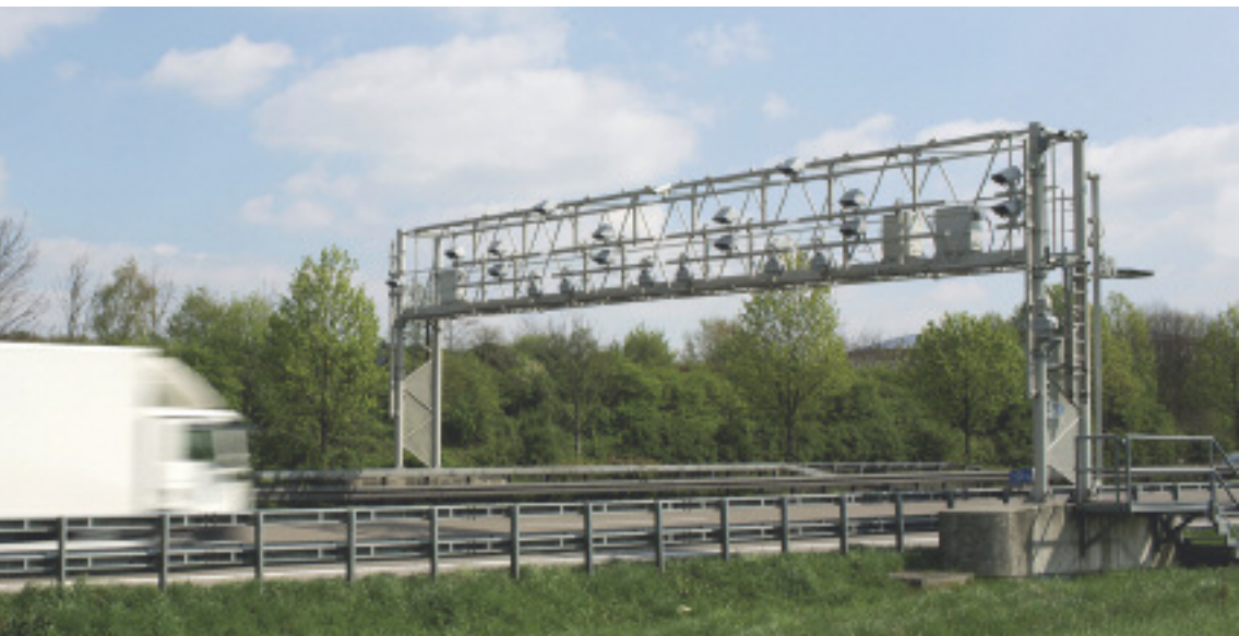
Mautkontrollbrücke auf der Autobahn A3 bei Langenfeld
