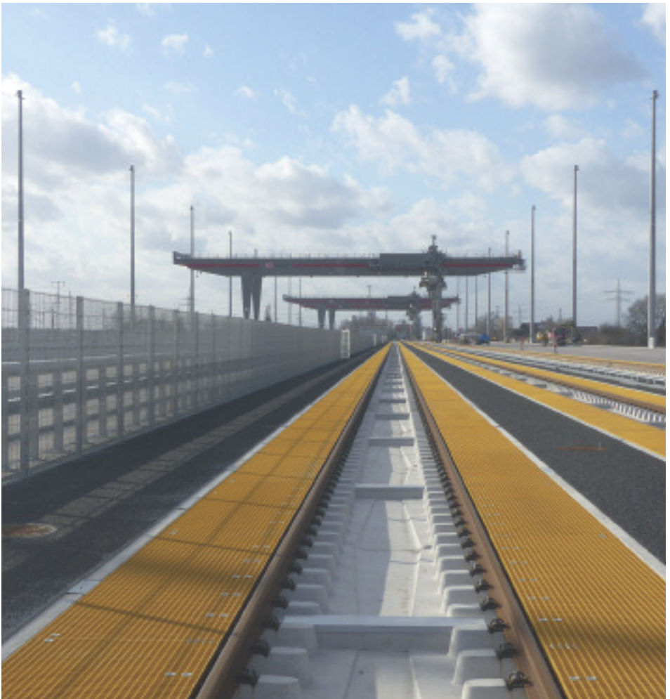
Bau einer Schnellumschlaganlage für den Kombinierten Verkehr in Lehrte
