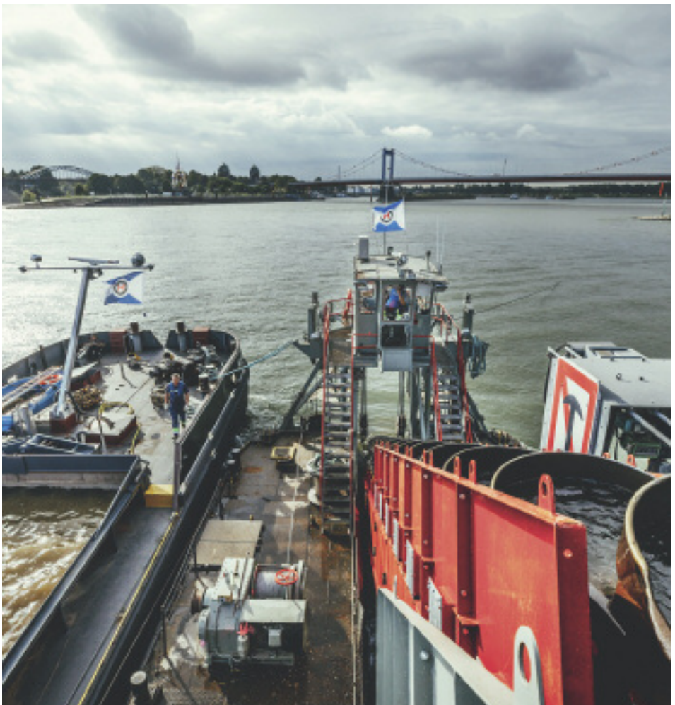
Eimerkettenschwimmbagger für zentimetergenaue Beseitigung von Geschiebematerial im Fluss
